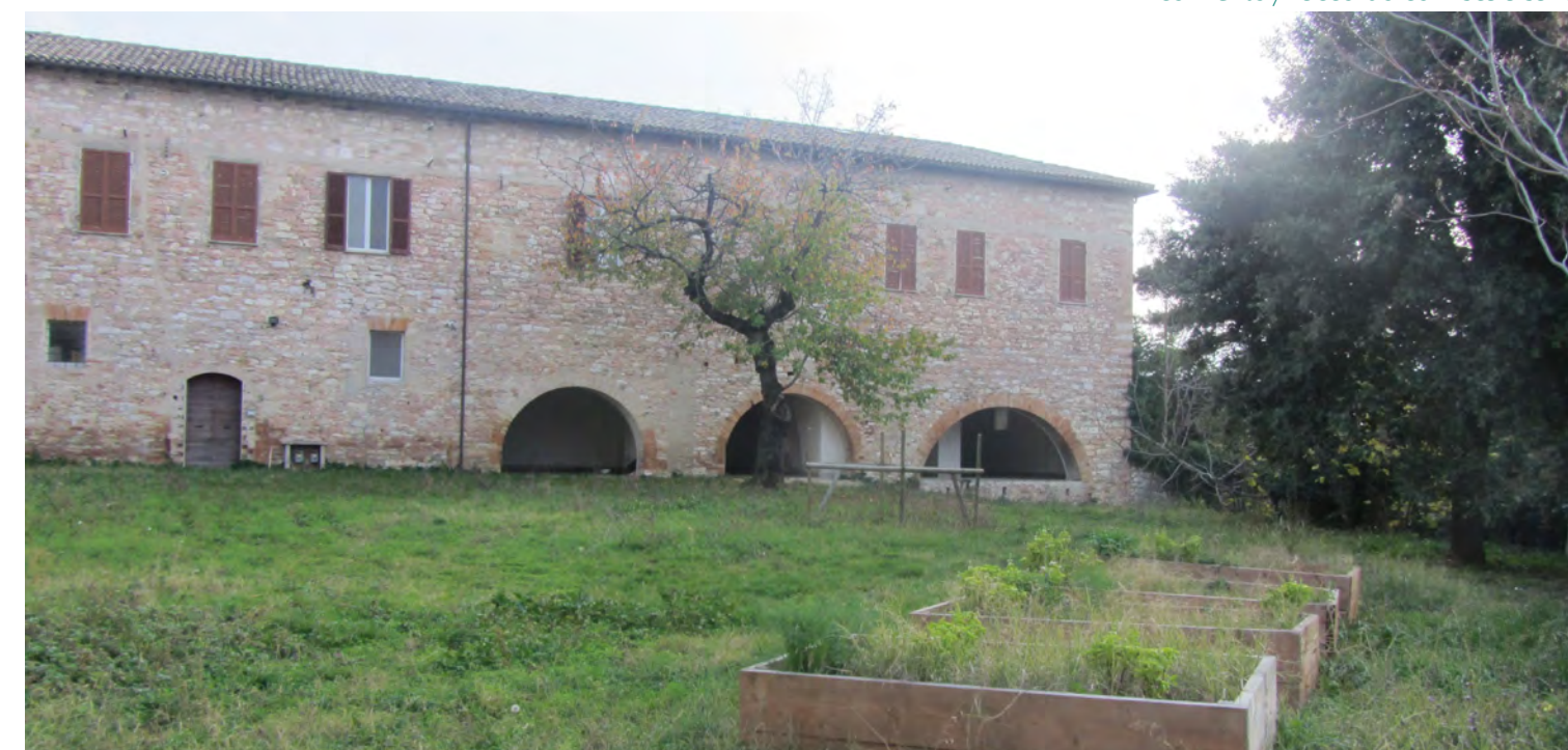
Ex-convento / ala a ridosso della cinta muraria
