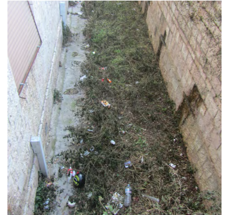
Liceo Scientifico, area verde in condizioni di degrado
