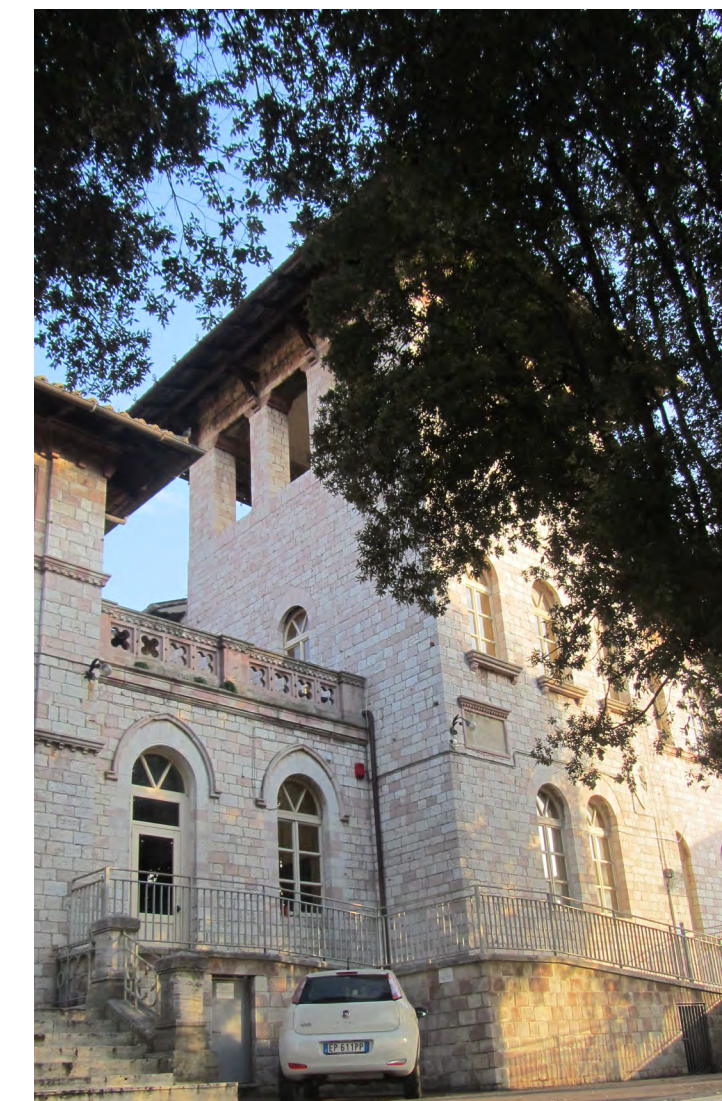
Torre a lato dell'ingresso principale
