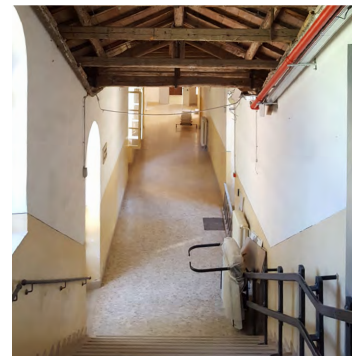
Scala di accesso alla palazzina / soffitto
