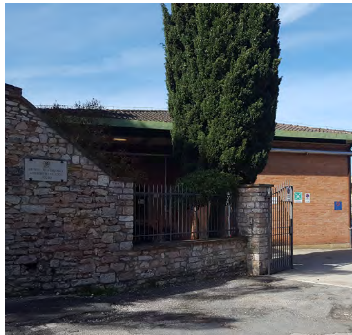
Istituto Alberghiero / ingresso
