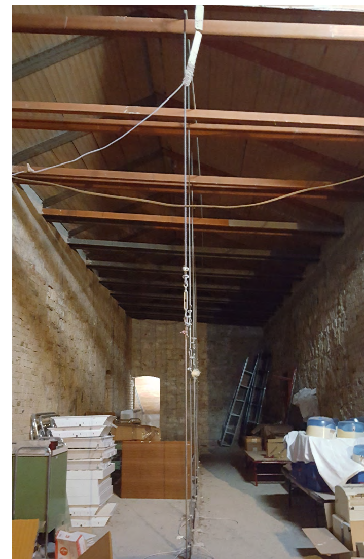
Blocco sud-ovest, soffitta accessibile
